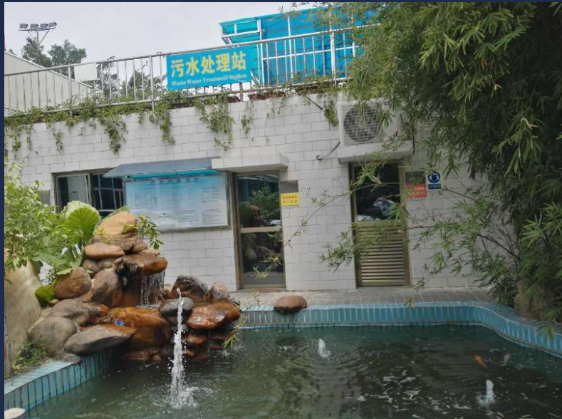
深圳污水处理站,2004年建成 Shenzhen Industrial Waste Water Disposal Center,2004
